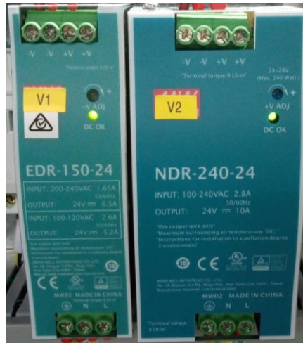
图 2-28 A8 驱动版开关电源
