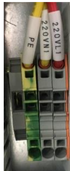
图 1-2 电源线接线
